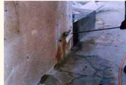
شكل 1-12 أعمال الحقن بمحاليل مقاومة النمل الأبيض
