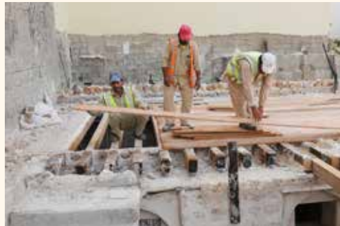
شكل 5 - 7 تثبيت ورص الدفوف الخشبية على السقوف
