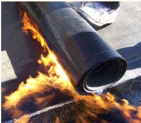
شكل 2-6 تسخين ألواح الطبقات العازلة
