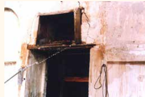
شكل 1-13 رش الأعتاب المصابة بمواد المقاومة
