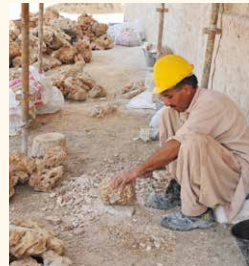
شكل 3-13 النحت اليدوي للأحجار بالمقاسات المطلوبة
