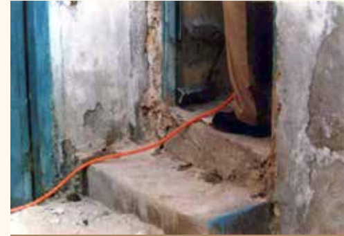
شكل 1-11 معالجة الحوائط السفلية ضد النمل الأبيض
