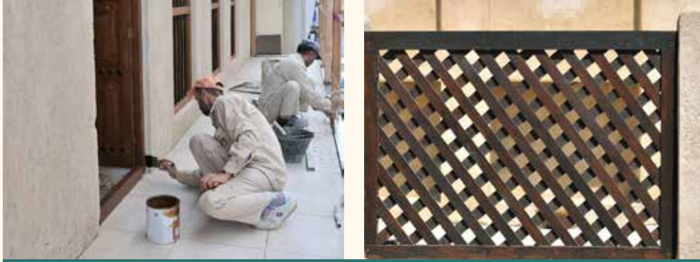
شكل 7-8 استخدام الأصباغ الزيتية في صبغ الأعمال الخشبية
