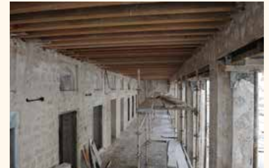
شكل 5 - 6 رص المربعات الخشبية على السقوف
