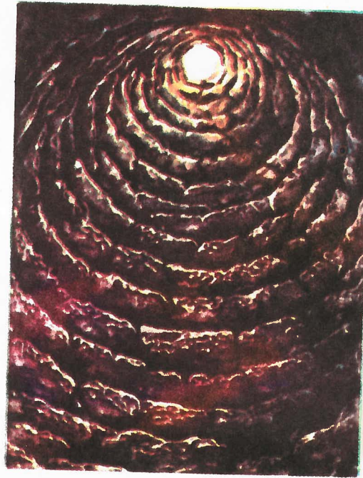
قبة إحدى القلاع . صفوف الأحجار تصبى نحو الداخل كلما ارتفعت . وقد استخدم نفس الأسلوب في قبور الشرق في عصر الحضارة قبل اليونانية
