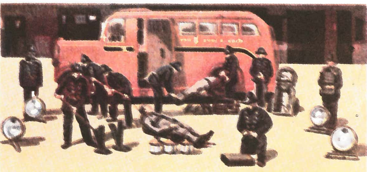
نقلات الطوارئ تحمل معدات خاصة مثل أجهزة التنفس والإنارة ، والملابس المصنوعة من المطاط (في حالة مواجهة المواد الكيميائية) .
